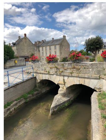
The bridge on the Mue | Photo : M. Lelandais
