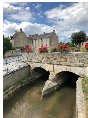
Le pont | Photo : M. Lelandais
